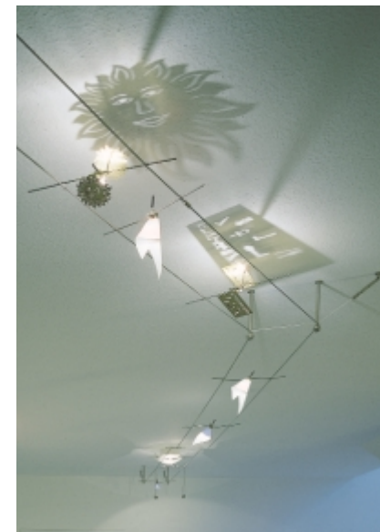
Seilsystem in beliebigem Winkel über Eck
