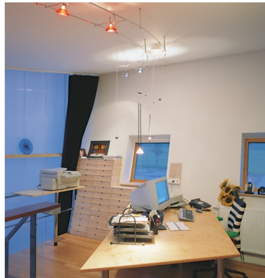
Lift IX und Lift I im Büroeinsatz
